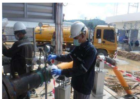
รูปที่ 3-1 การติดตามตรวจสอบคุณภาพน้ำทิ้งจากการทดสอบท่อ ด้วยวิธีทางชลสถิต (Hydrostatic Test)
